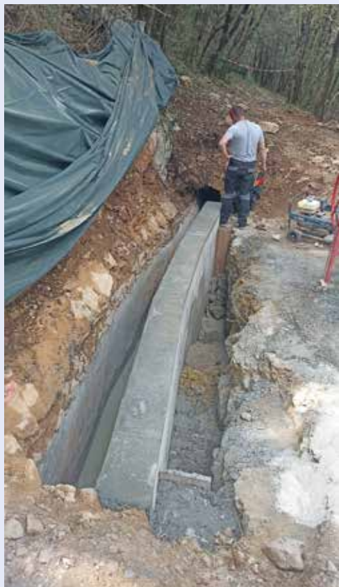
Réparation du canal romain historique
