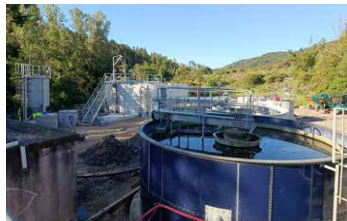
Retour en images sur la réhabilitation de la station d'épuration des Esterets du Lac
