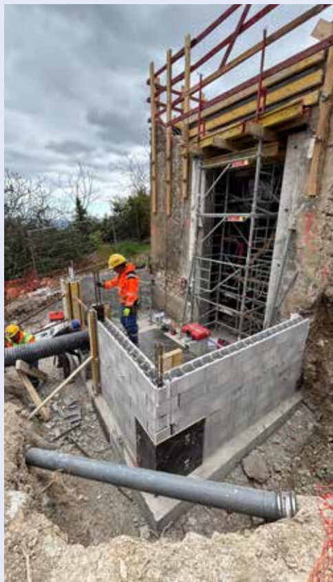
Réhabilitation du réservoir du Foulon à Seillans dans le cadre de la sécurisation en eau potable
