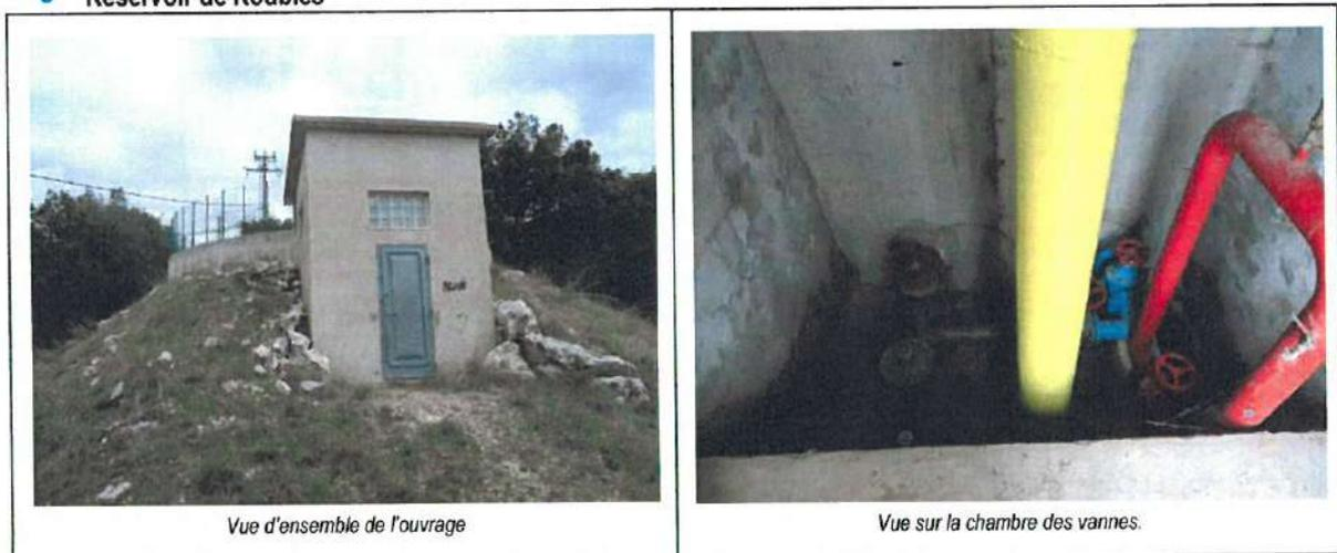
Le génie civil du réservoir est correct. Les équipements hydrauliques montrent de légères traces de corrosion.
