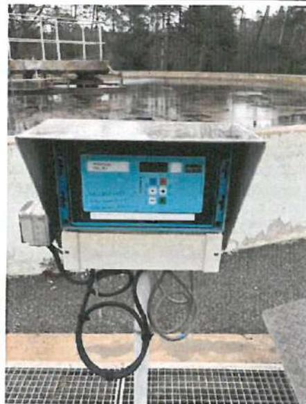
*Vue sur le clarificateur et le dispositif de comptage*
